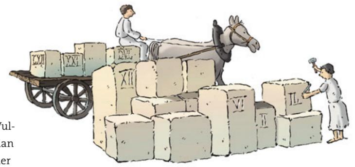
Die Steine zum Bau der Kathedrale wurden schon in den Steinbrüchen von erfahrenen Steinmetzen gekennzeichnet. Anhand dieser Markierungen wusste man genau, wo sie nachher verbaut werden sollten.
