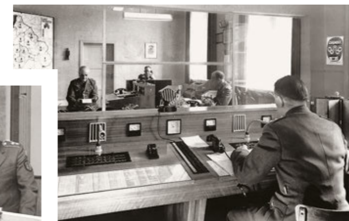
Funksprech- und Aufnahmerraum der Einsatzleitstelle, Essen 1961
