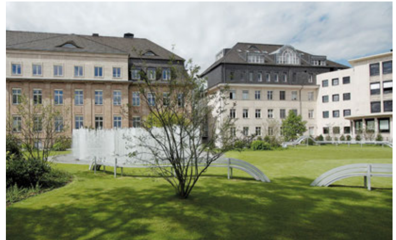
Der 2007 bezogene Gebäudekomplex Oppenheimstraße 9–11 von der Gartenseite aus
