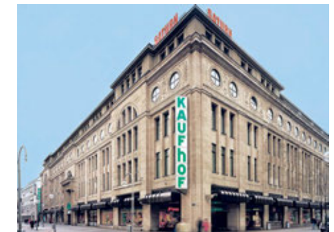
Der repräsentative Bau des Kaufhofs, 1912–14
