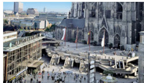
Treppenläufe nördlich des Doms vor der Neu- gestaltung ab 2004
