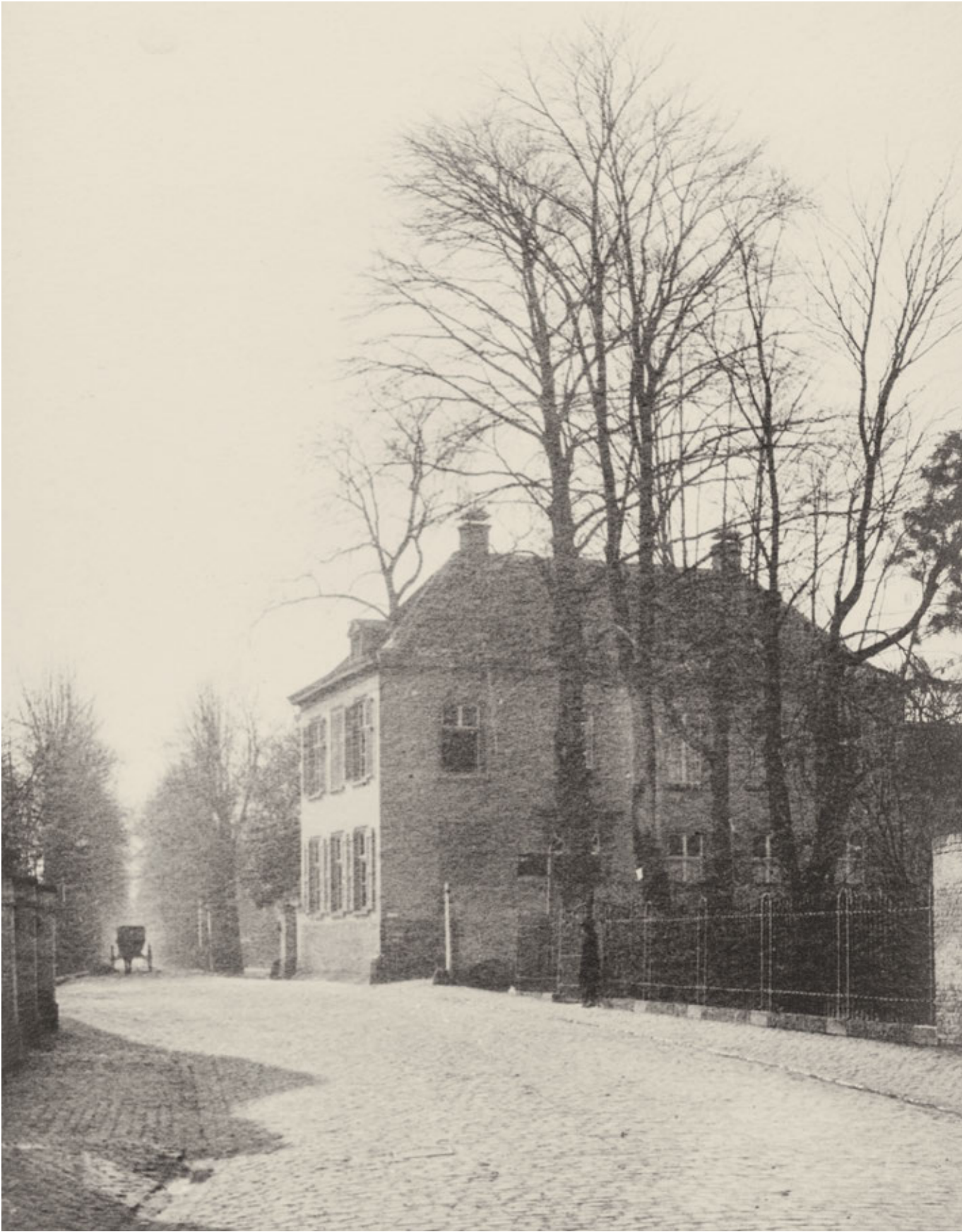
Kleve, Eckhaus, Nassauer Allee
